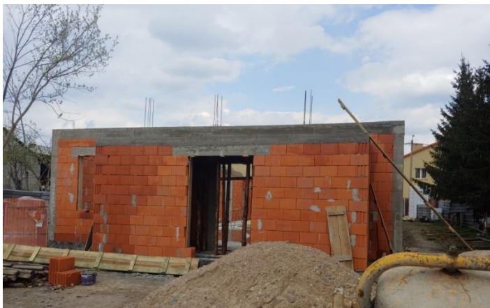
Obiekt Centrum rozwoju przedsiębiorczości w trakcie budowy
