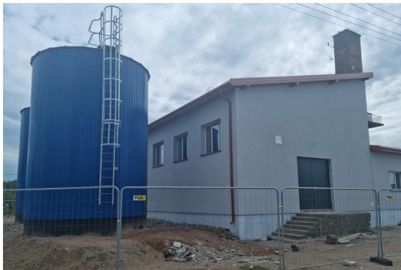
Przebudowywana Stacja Uzdatniania Wody w m. Szczuczyn
