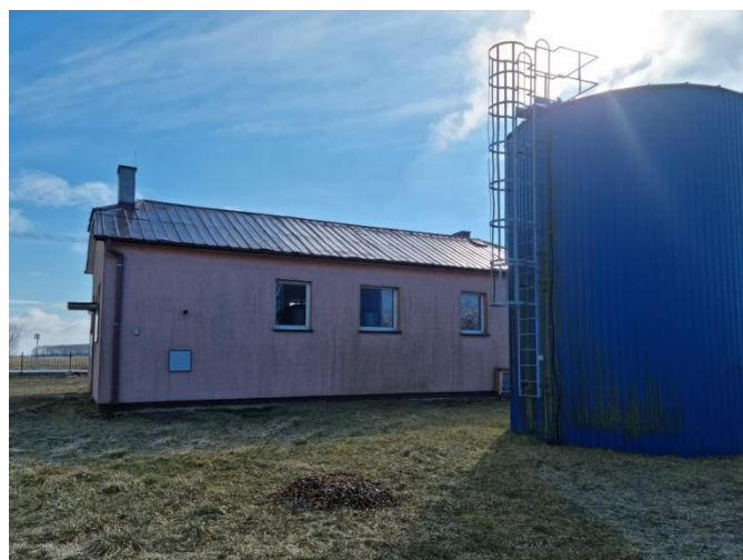
Stacja Uzdatniania Wody w miejscowości Niedźwiadna
